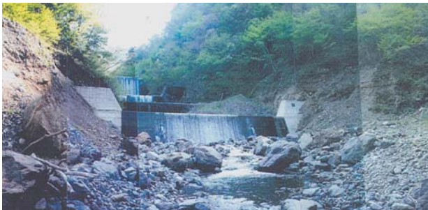
写真1 大塔寮上流に設置されていた堰堤群
