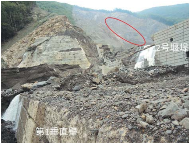
図5 2号堰堤と第1垂直壁。後方に見える赤丸部分にあった100万m 3 の土砂が崩落した(2014年8月26日)
