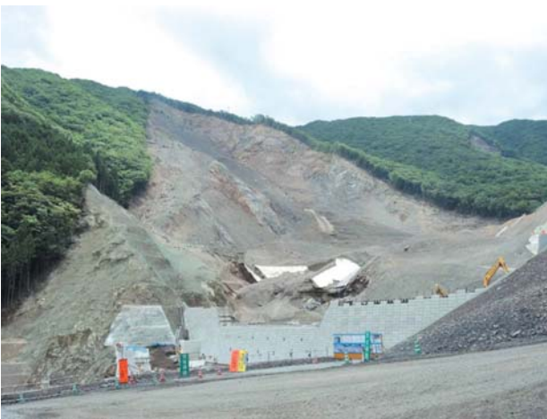
図1 大分完成してきた2号堰堤と深層崩壊現場(2014年7月7日)
