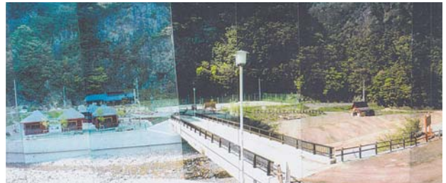
写真6 完成直後のオートキャンプ場
