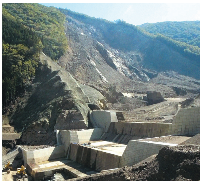
左写真：完成しつつある2号堰堤と赤谷深層崩壊地 (2015年10月16日撮影)
