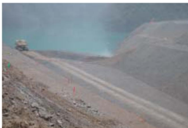
土砂ダム直下の排水路
