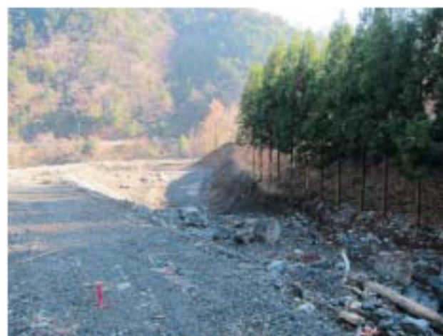
赤谷の橋下流（災害後）
