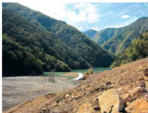
赤谷の土砂ダム
