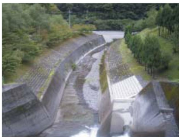
赤谷の橋下流（災害前）
