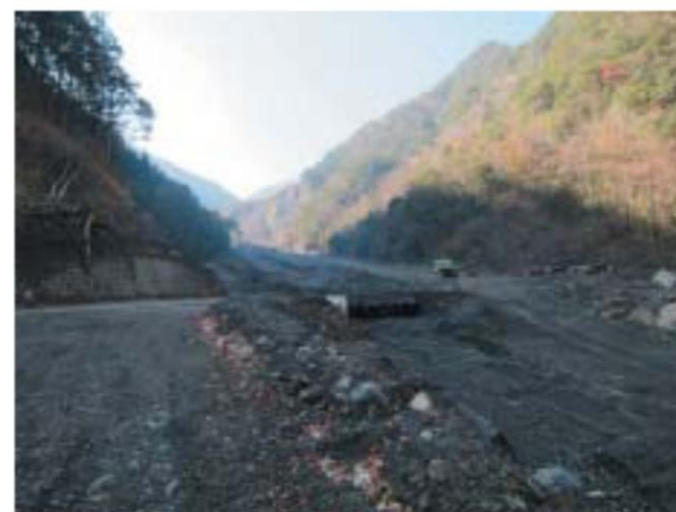
赤谷の橋上流（災害後）
