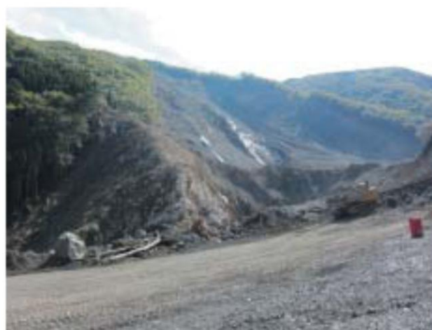
崩落現場の最下部
