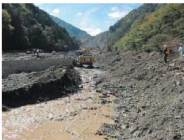
赤谷の橋上流工事風景
