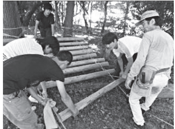
図3 仕上げの吊り橋の作業
