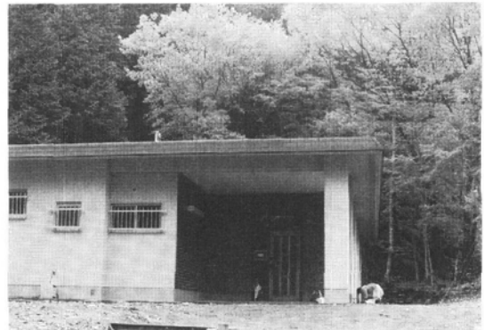
大塔寮の正面（背後はコナラとスギの植林） (1990年5月5日撮影)
