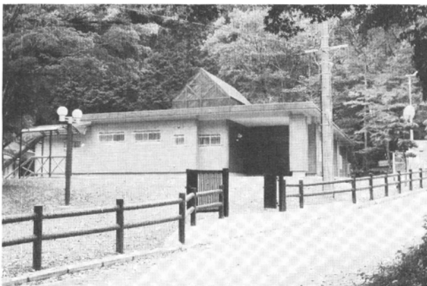
改築された実習林の宿泊施設「大塔寮」
