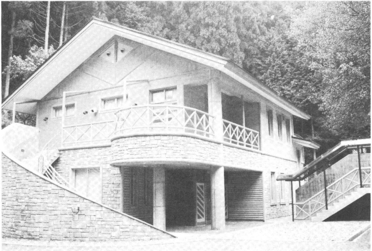
完成した奥吉野実習林教育・研究棟
