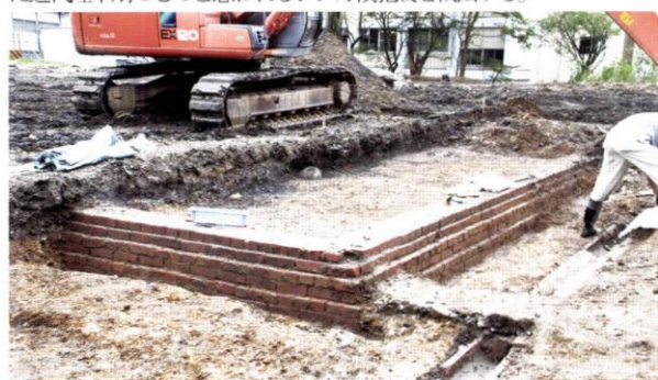
第5図 近代陸軍レンガ積建物基礎の検出
