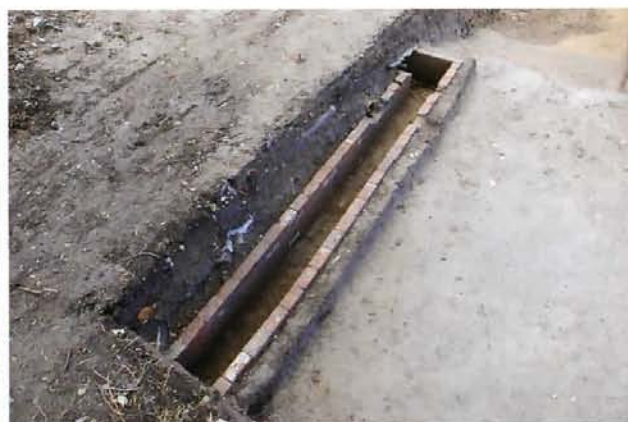
3 08 A区 レンガ積地下通信ケーブル坑 (南東から)
