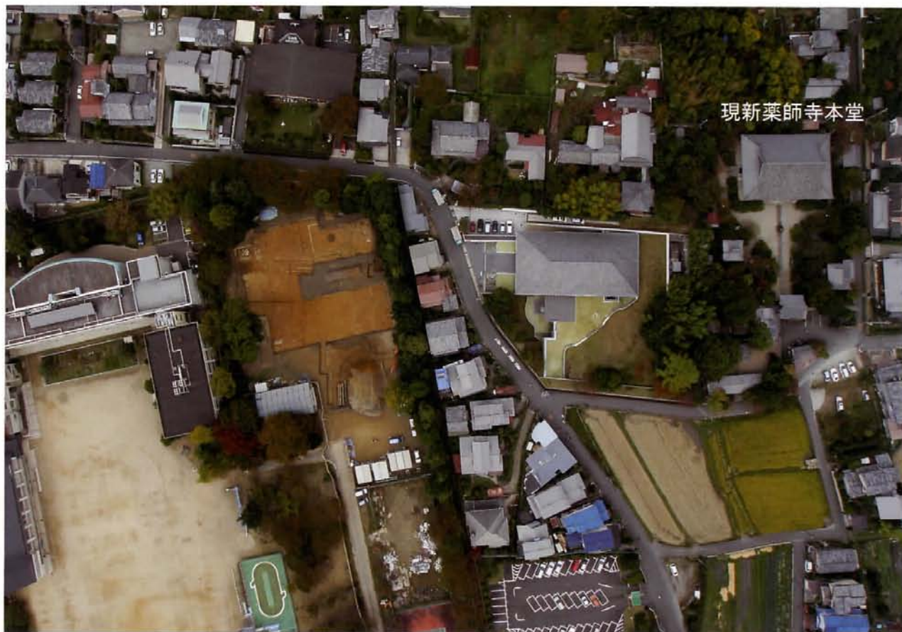
2 08年度調査区 全景（真上から）
