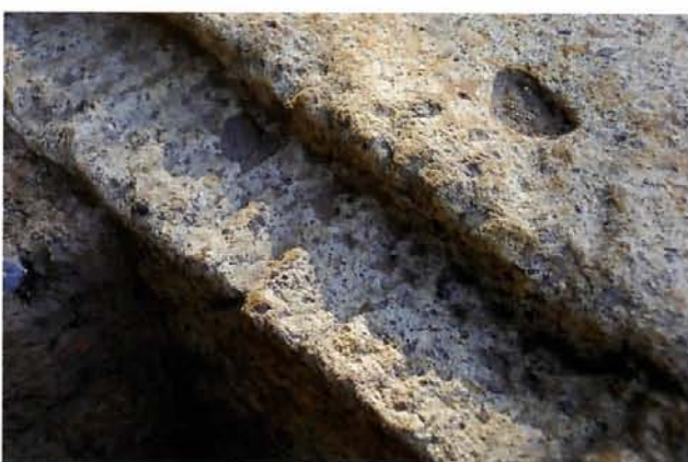
7 基壇地覆石背面の工具痕 (北西から)
