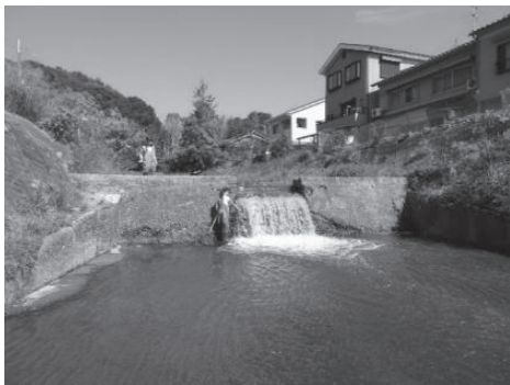
【図 9】浚渫工と共に造られた治水対策用の町中の堰堤
