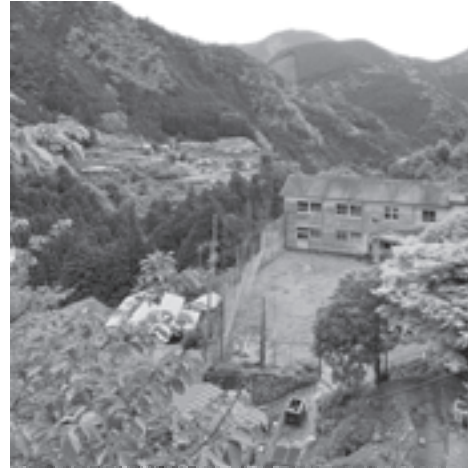
図4 校舎遠景:建物の手前がグラウンド(同)
