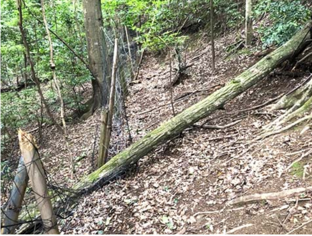
図1. 木製支柱は折れている
