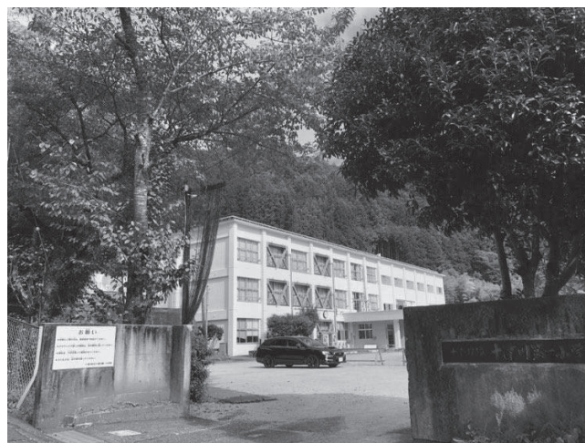
図2 十津川村立十津川第一小学校 外観 (2020年8月27日、河本撮影。)
