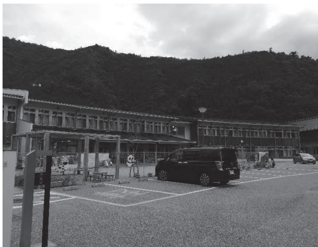
図3 十津川村立十津川第二小学校 外観 (2020年8月25日、大辻撮影。)
