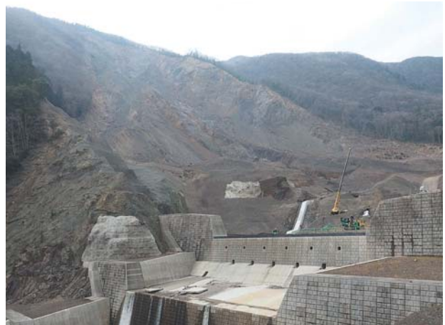
2号砂防堰堤と建設始めた3号砂防堰堤
