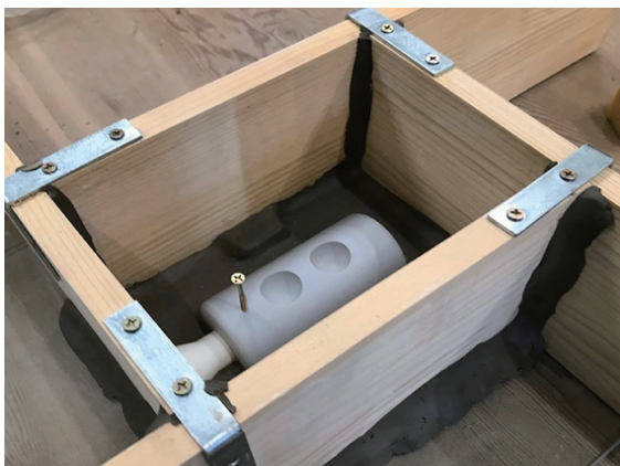
図14 外枠まで設置した状態
