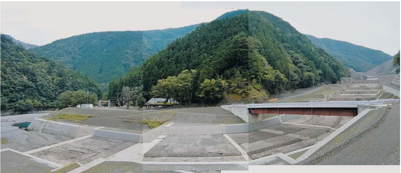
赤谷対岸から見た実習林。下流の溪流保全工から1号・2号砂防堰堤が見えている
