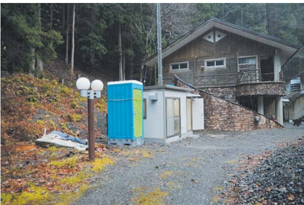
実習林に設置したプレハブ事務所とトイレ
