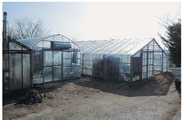
新パイプハウスと張り替えたビニルハウス
